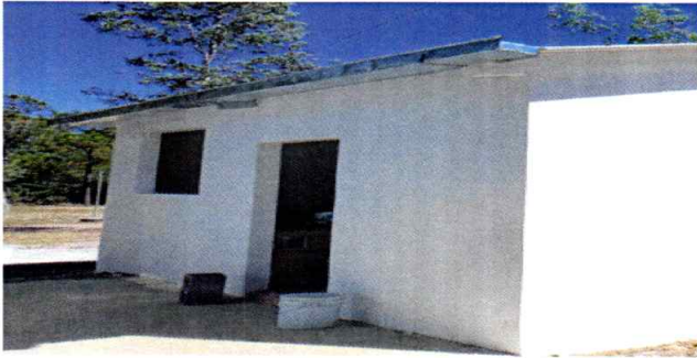
Foto 1: Realizando mejoramiento en cubierta de lámina, estructura de soporte, puertas, ventanas, piso, sistema eléctrico, estufa rural, mueble de concreto y lavatrastes
