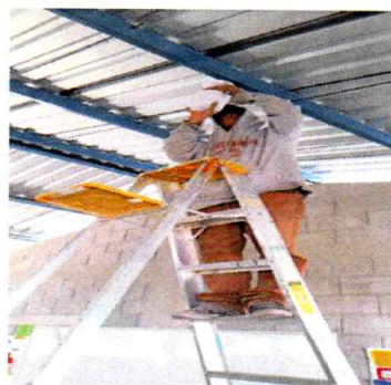
Foto 2: Instalación de lámparas
