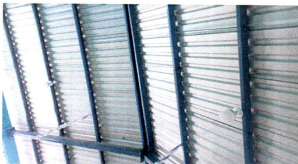
Foto1: Instalación de lámparas
