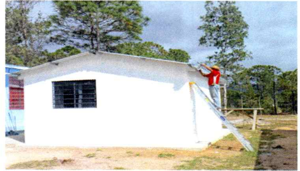
Foto 2: Realizando mejoramiento en cubierta de lámina, estructura de soporte, puertas, ventanas, piso, sistema eléctrico, estufa rural, muebles de concreto y lavatrastes
