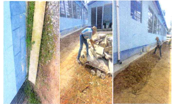
Foto 4: Haciendo mejoramiento de banqueta en mal estado del modulo
