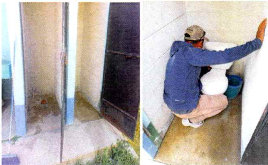
Foto 5: Instalación de sanitarios
